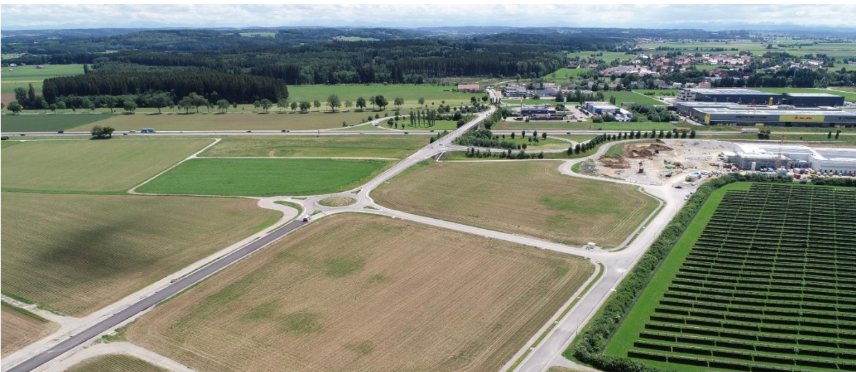
Luftbild: Beginn der St2020 an der Anschlussstelle Holzgünz der A96 mit Anschluss und Erschließung des Gewerbeparks über einen Kreisverkehr, Weiterführung der St2020 nach Norden
