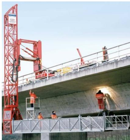
Handnahe Prüfung einer Brücke (deutsches Ingenieurblatt)
