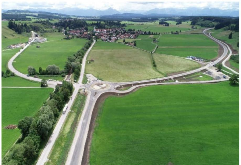
**Nordportal Tunnel Bertoldshofen offene Bauweise im Voreinschnitt und Rohbau des Tunnelbetriebsgebäudes**
