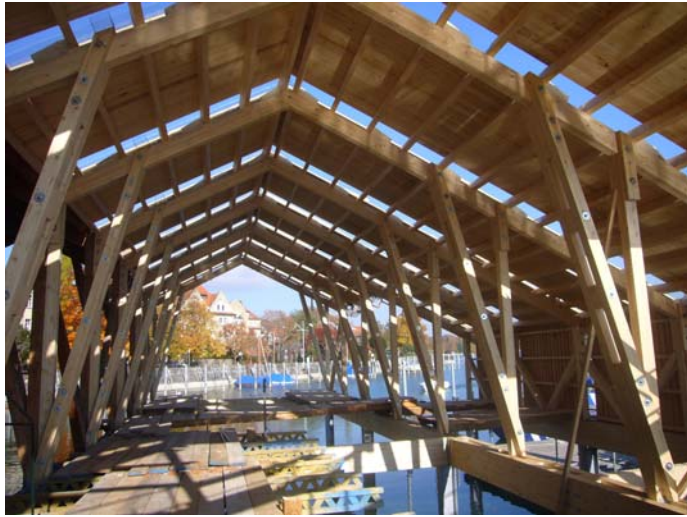
Erweiterung Bootshaus Seemeisterstelle Lindau
