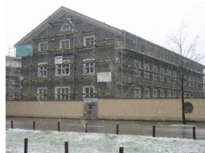
Kaserne Füssen, Unterkunftsgebäude - Ausbau Dachgeschoß
