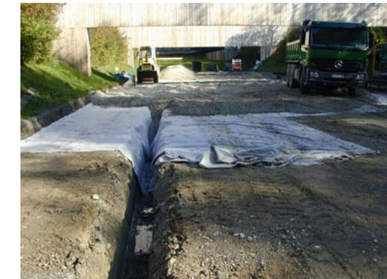
Umbauarbeiten Standortschießanlage Füssen
