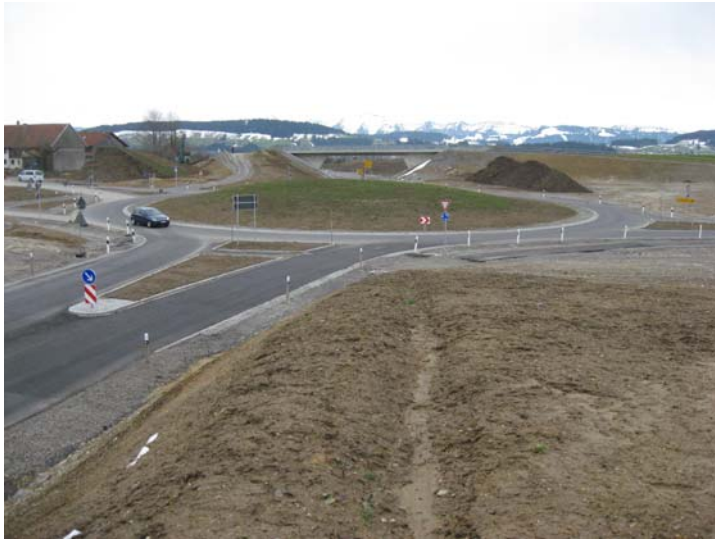
B 32, Verlegung südlich Heimenkirch
