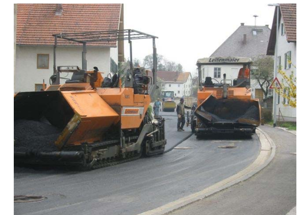
St 2011 Ausbau der Ortsdurchfahrt Attenhausen
