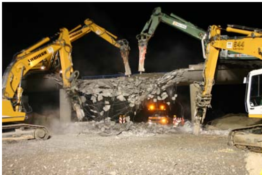
Abbruch einer Feldwegüberführung über die B 12 bei Buchloe
