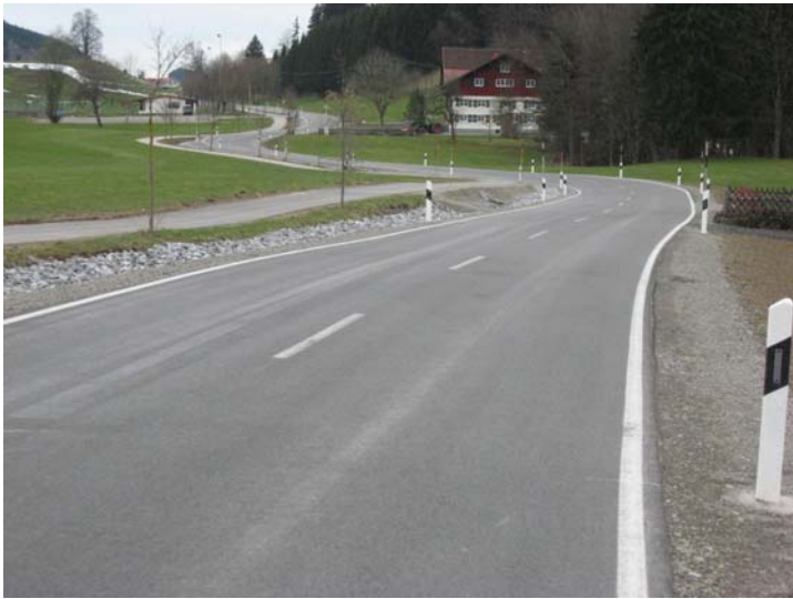
Ausbau Kreisstraße Li4
