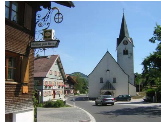
St 2005 Ausbau der Ortsdurchfahrt Aach, Oberstaufen
