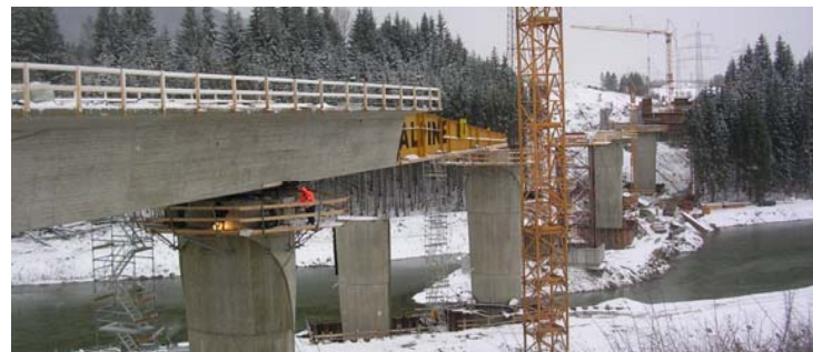
B 19 neu, Bau der Illerbrücke bei Thanners
