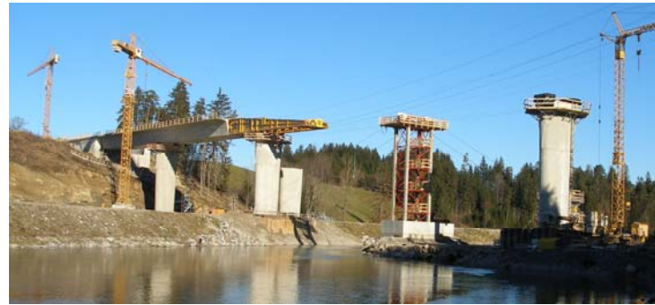
B 19 neu, Bau der Illerbrücke bei Thanners
