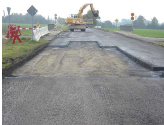
St 2037 Deckenbau nördlich Pfaffenhausen
