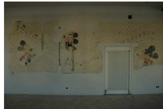
Kaufbeuren TSLw1; Ausbau der Truppenküche bei der Sanierung zutage getretene „Kunst am Bau“
