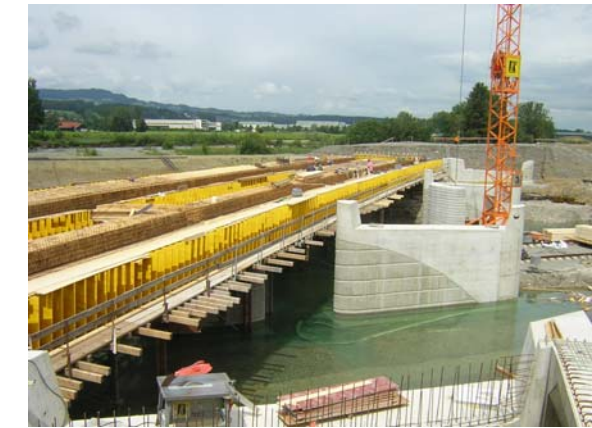
Neubau der Brücke über die Flutrinne B 19 neu
