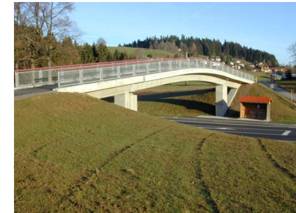
Geh- und Radwegbrücke bei Oberreute über B 308
