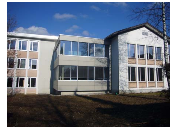
Erweiterungsbau beim Gymnasium Lindenberg
