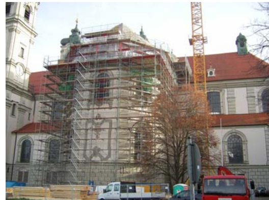
Basilika Ottobeuren, Dachsanierung
