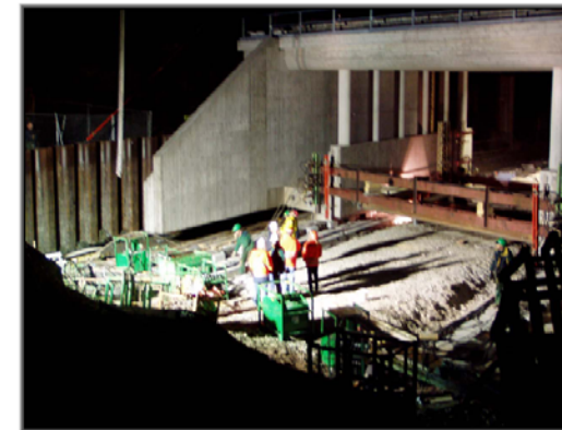
Einschub der Brücke bei Nacht
