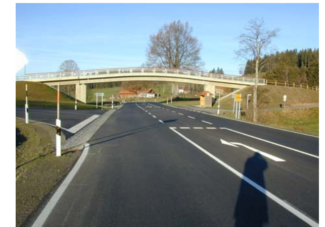
B 308, Neubau Geh-/Radwegbrücke bei Oberreutte
