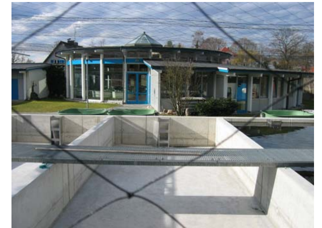
Außenbecken Fischbrutanstalt Nonnenhorn
