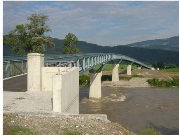
Geh- und Radwegbrücke über die Iller und B 19 neu
